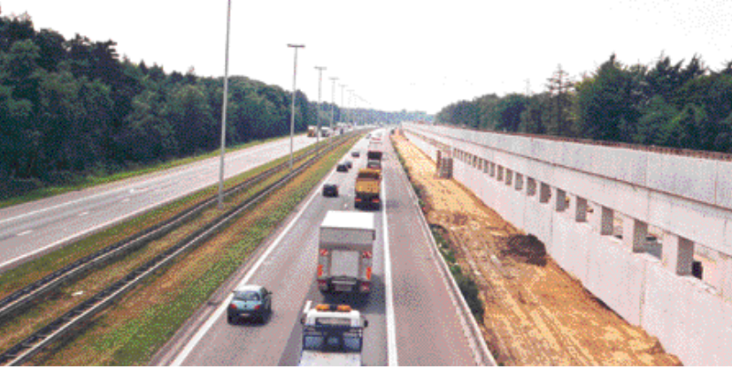
De hsl en de autosnelweg Antwerpen-Breda lopen evenwijdig.
